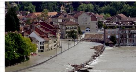
Abb. 3: Aare in Bern beim Hochwasserereignis am 24. August 2005 (© AWA Amt für Wasser und Abfall des Kantons Bern, Foto: Beat Baumann)
